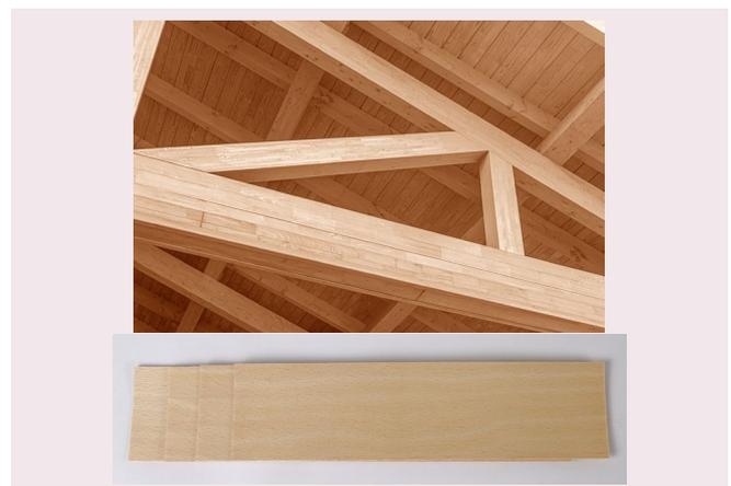
Abbildung 30: Leimbinder bestehen aus parallel verleimten Hölzern. Das kann auch mit Furnieren nachgestellt werden. ©Adobes Stock / proHolz Steiermark / © Wood Vision Lab
